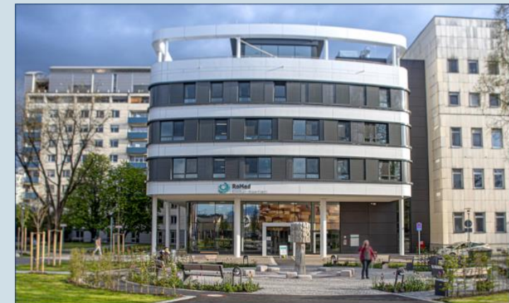
Inn-Kühlung am Krankenhaus
